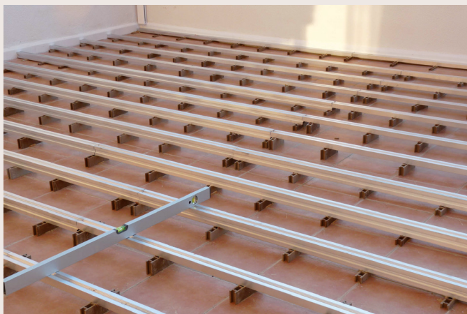
22. Rastrelado para junta perdida.
