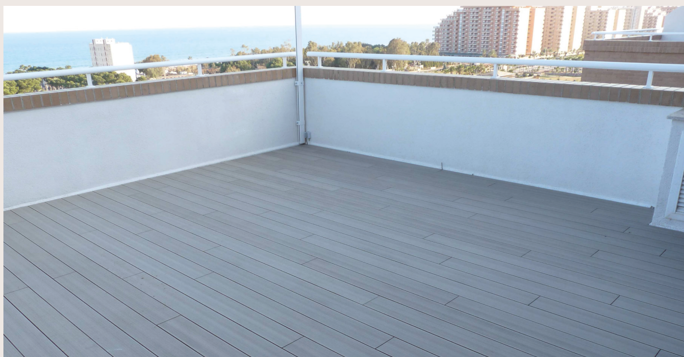
24. Tarima montada a junta perdida.
